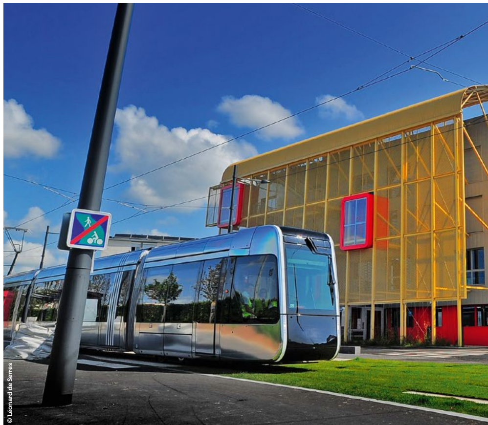
La pépinière d'entreprises de Joué-lès-Tours.
