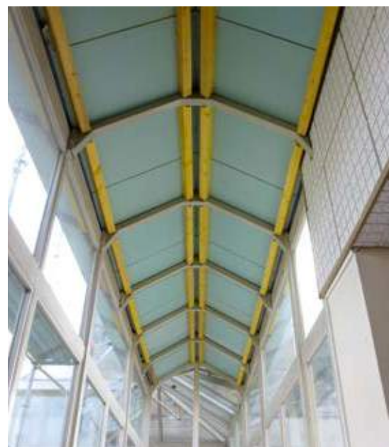
Des panneaux sandwich sur le toit comme sur les soubassements isolent désormais du froid hivernal comme des rayons ardents du soleil l'été.
