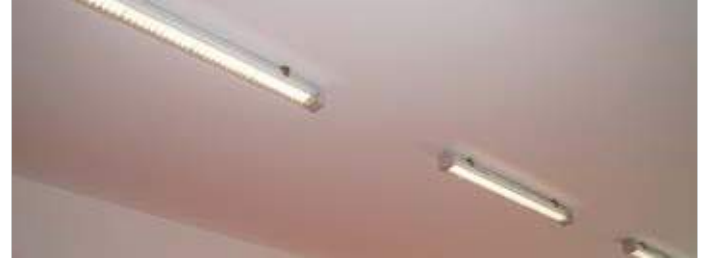
900€ de moins sur la facture annuelle de consommation grâce à la baisse de 78% de la puissance électrique.
