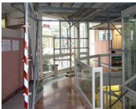
Les échafaudages dans le hall central au 1 er étage enserrant l'ascenseur ont permis de remplacer la coupole de verre datant de la fin des années 80.
