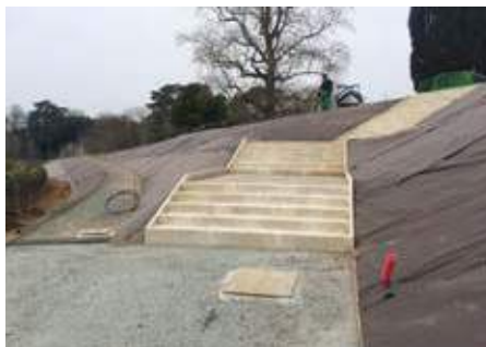
La pente abrupte a été remplacée par un escalier de pierre. Le granit choisi est d'origine européenne.
