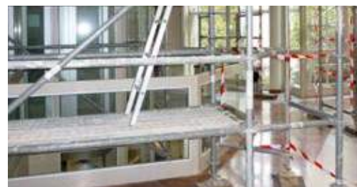
Les échafaudages dans le hall central au 1 er étage enserrant l'ascenseur ont permis de remplacer la coupole de verre datant de la fin des années 80.
