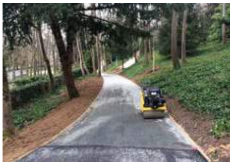
9 chênes qui avaient dû être arrachés de long de l'avenue André Ampère en travaux, ont retrouvé une nouvelle destinée dans le parc.
