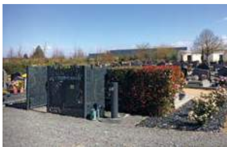
Les sites destinés aux conteneurs de végétaux fanés sont masqués par des claustras métalliques ajourés.
