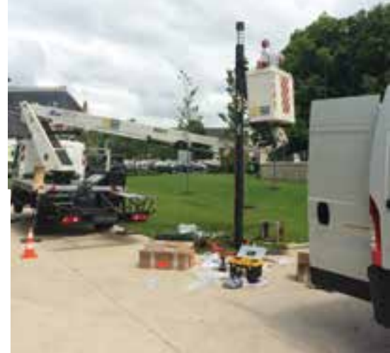
Travaux du parvis de l'hôtel de ville.
