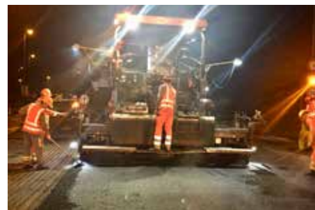
24 Des travaux d'envergure
