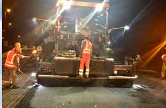
Giratoire Pierre Vialle Pose des enrobés dans la nuit du 22 octobre.
