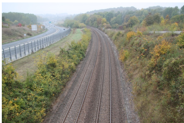
Voie ferrée en limite Nord-Ouest du territoire
