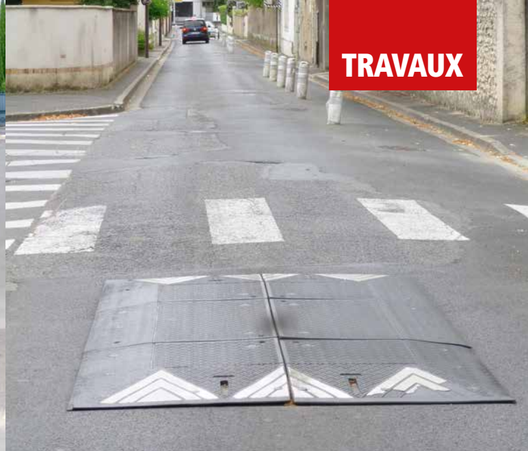
Pour tester la configuration de l'aménagement futur, des balises avaient été placées en anticipation sur la chaussée afin de préfigurer la future largeur de la chaussée.
