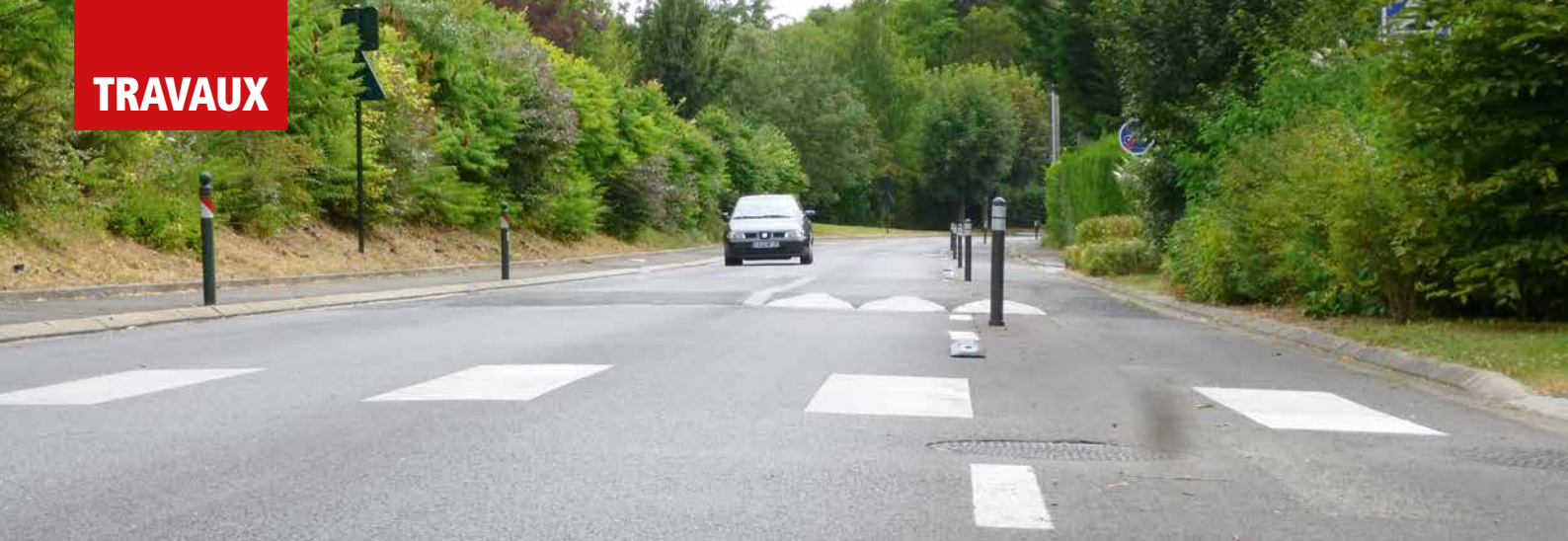
Renforcement de la signalisation, sécurisation des pistes cyclables et dos d'âne rue des Rimoneaux.
