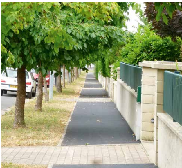
Campagne de réfection de différentes rues et trottoirs.
