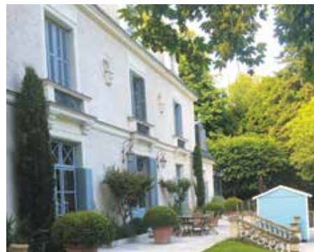
Les travaux de restauration se sont étalés sur 3 ans.
