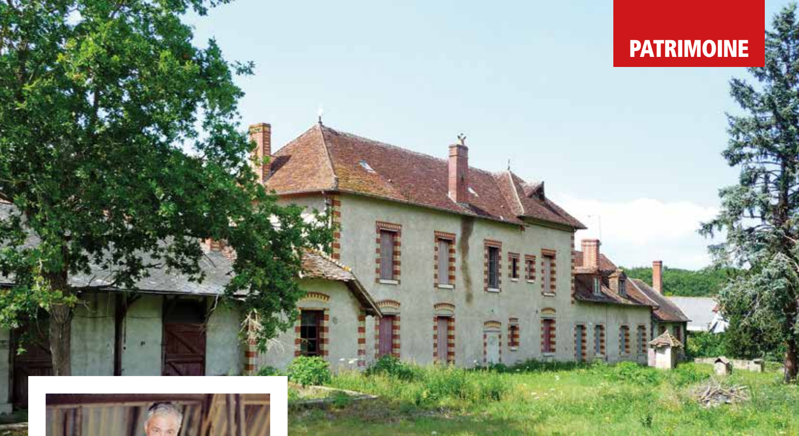
La Rablais - Façade est (2010).
