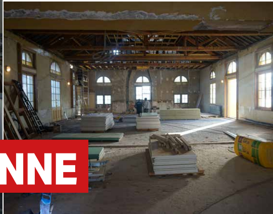
Les travaux de l'ancienne mairie
