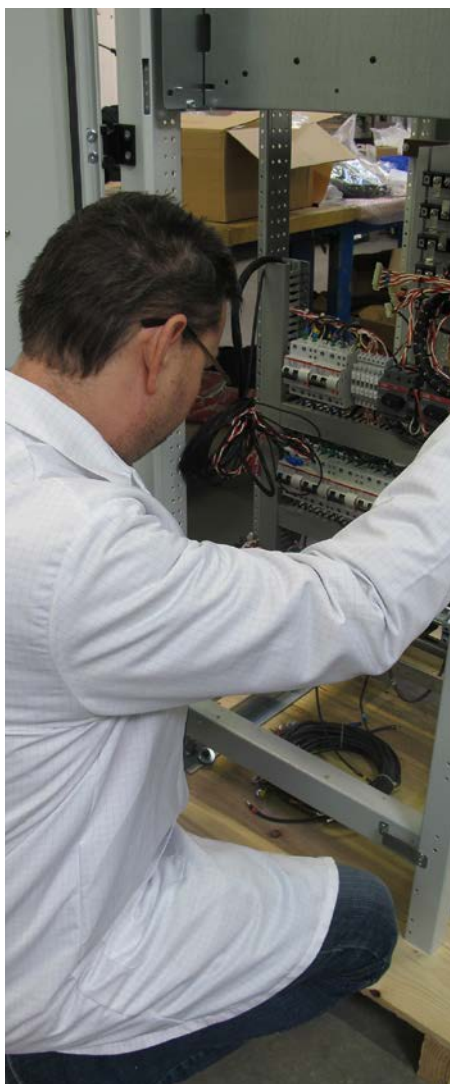
Le câblage des armoires électriques.
